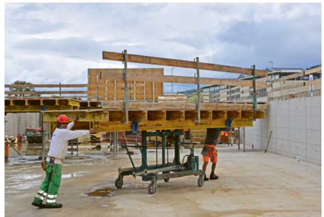
5 Deckenschalungselement mit vormontiertem Kollektivschutz (dreiteiliger Seitenschutz) wird versetzt.
