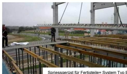
Spriessgerüst für Fertigteile= System Typ B
