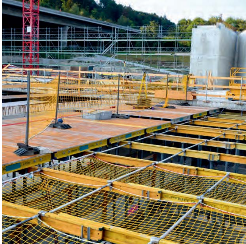
Flexibel einsetzbar: Kollektive Sicherung für die Arbeiten rund ums Deckenschalen, einsetzbar ab 2.00 Metern.
